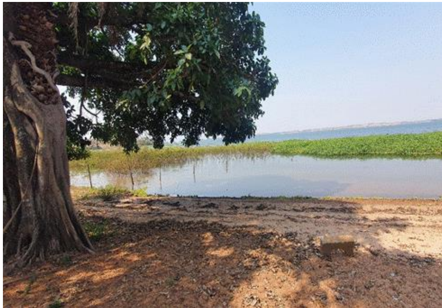
Figura 115 -Ponto de passagem do emissário, Rio Paraná. Fonte: Visita técnica. A Figura 116 abaixo mostra o caminho feito pelo emissário.
