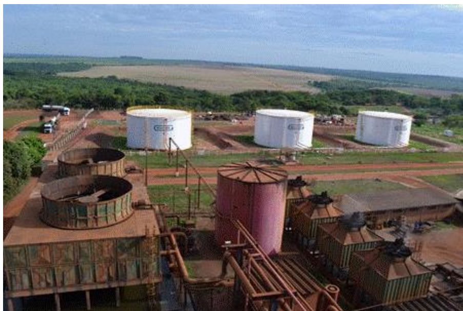
Figura 18. Estrutura industrial da Usina Alcoolvale. Fonte: Alcoolvale. Acesso 29/04/23.
