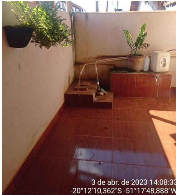
Figura 120. Poço em zona rural. Fonte: Visita técnica, 2023.
