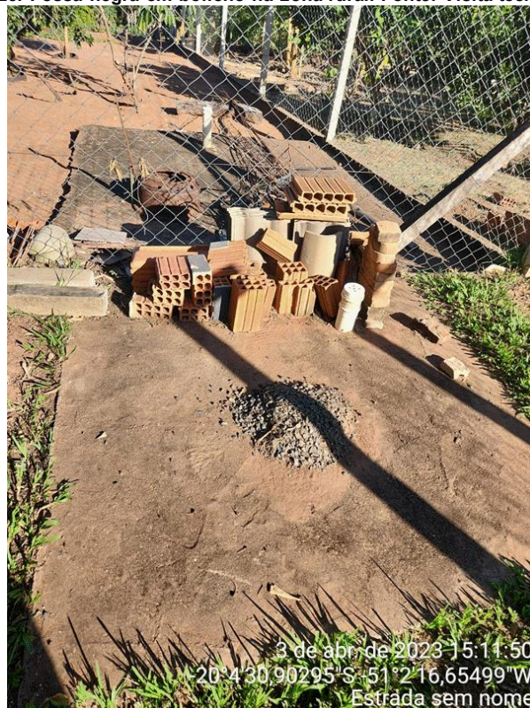
Figura 126. Fossa séptica em chácara no condomínio Enseada Três Rios. Fonte: Visita técnica, 2023.
