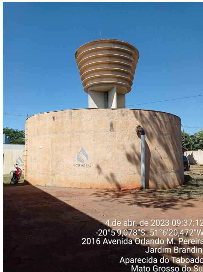
Figura 66- RAP-01 e REL-001. Fonte: Visita técnica.
