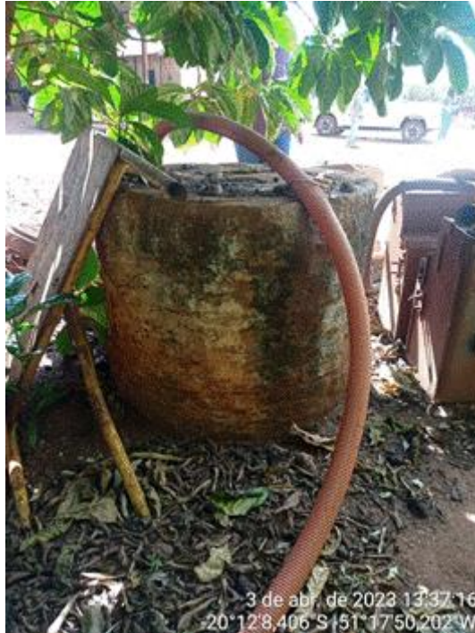
Figura 118 - Poço que abastece a oficina. Fonte: visita técnica.
