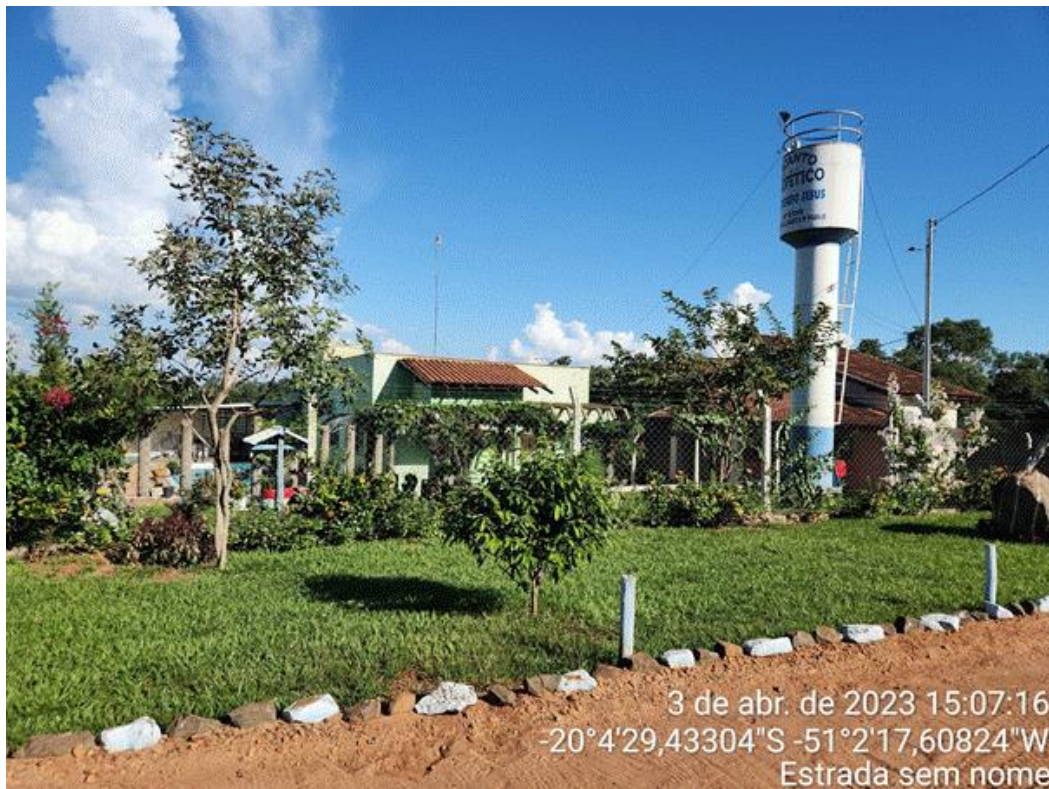
Figura 122 - Reservatório em chácara na zona rural. Fonte: Visita técnica.
