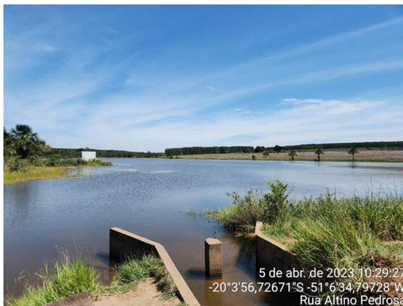
Figura 82 – Represa do córrego Campo. Fonte: Visita técnica
