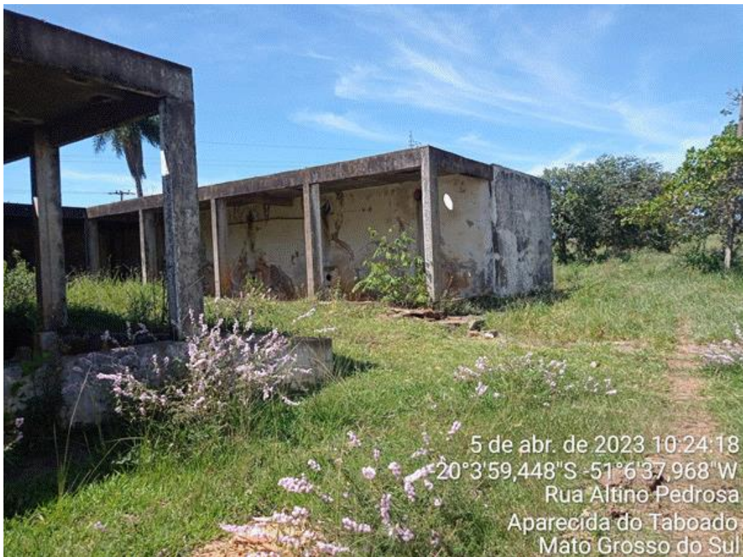
Figura 80 – Provável estrutura dos decantadores. Fonte: Visita técnica.
