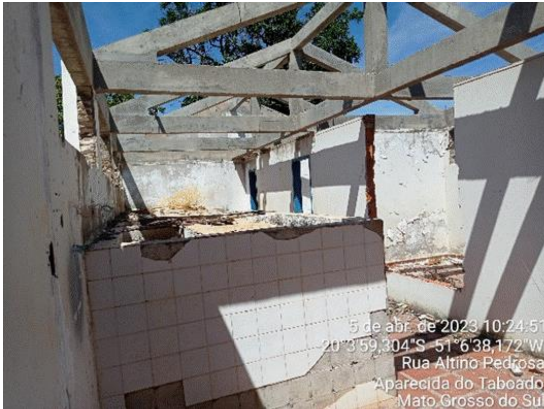
Figura 81 – Interior da antiga Casa de Química. Fonte: Visita técnica.
