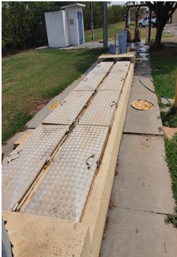
Figura 102- Desarenadores com a EEEB ao fundo. Fonte: Visita técnica.
