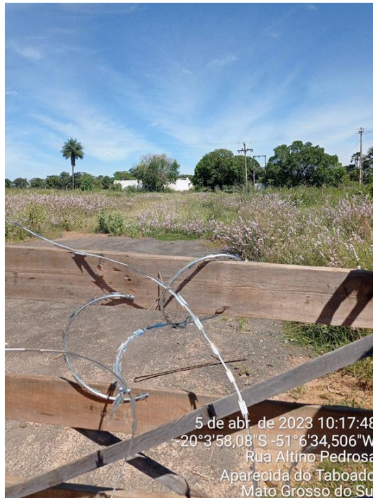
Figura 76 – Acesso a ETA desativada. Fonte: Visita técnica.
