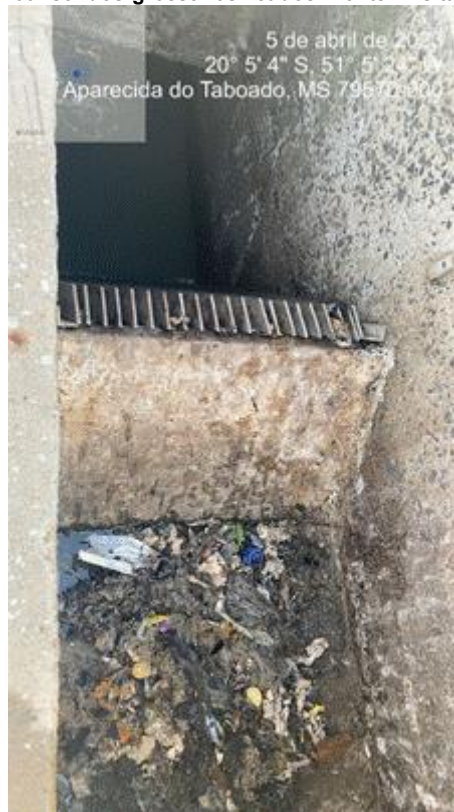
Figura 101 - Gradeamento de sólidos mais finos. Fonte: Visita técnica.
