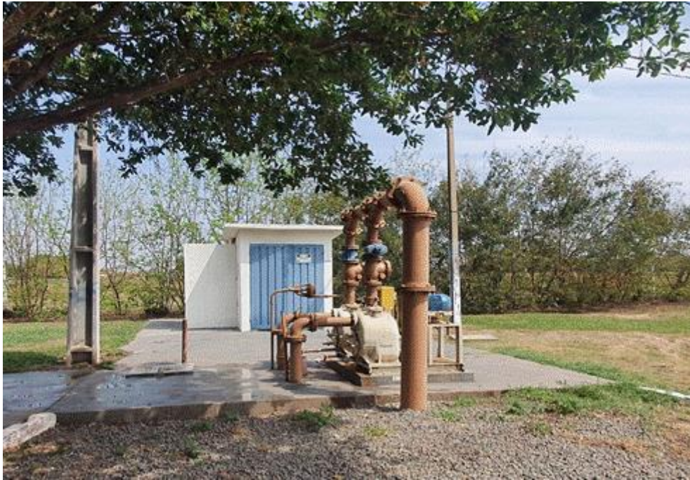
Figura 93- EEEB. Fonte: Visita técnica.
