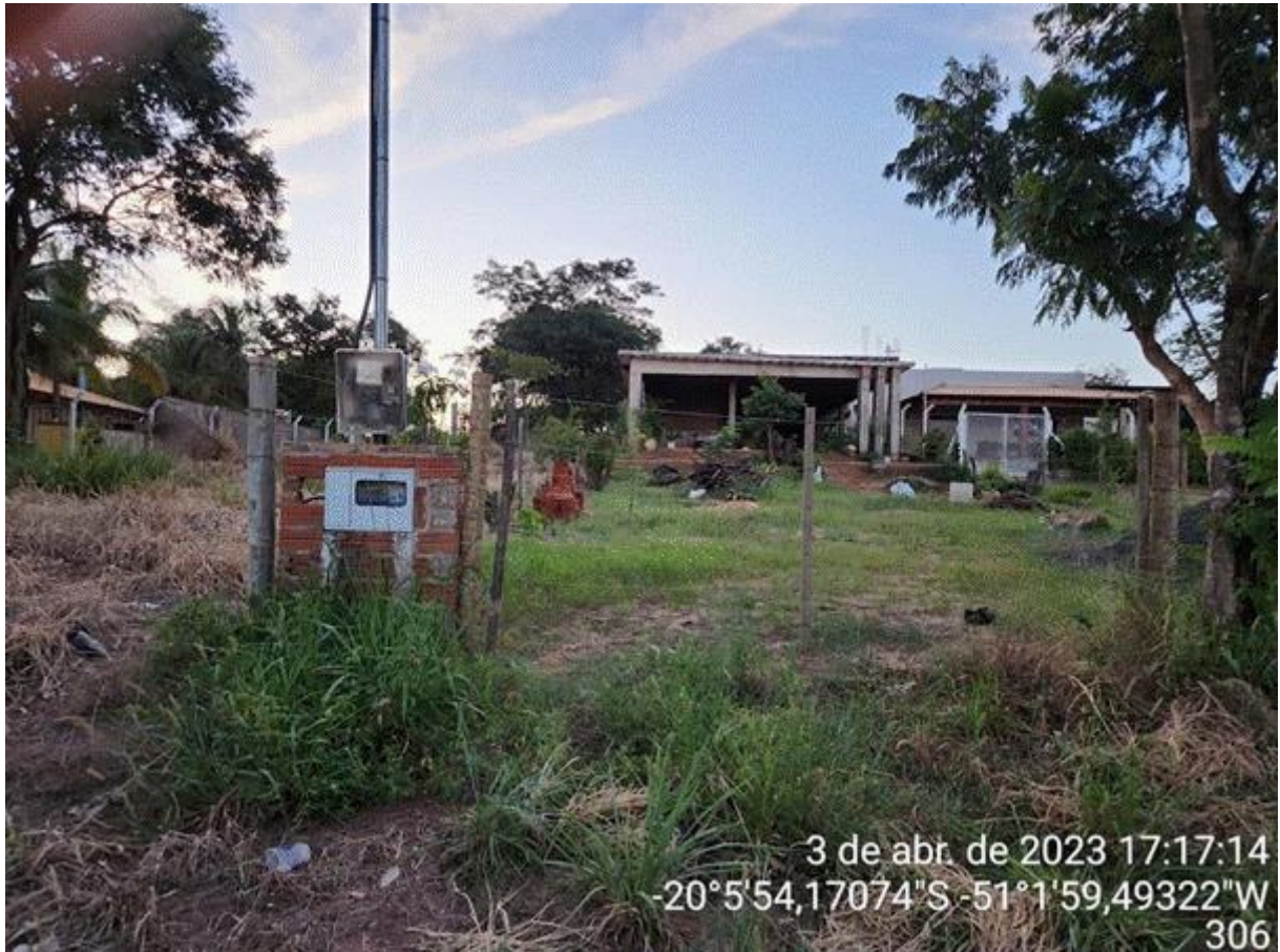
Figura 42 - Residência em construção com cavalete padronizado, no loteamento Andaralúá I. Fonte: Visita técnica.
