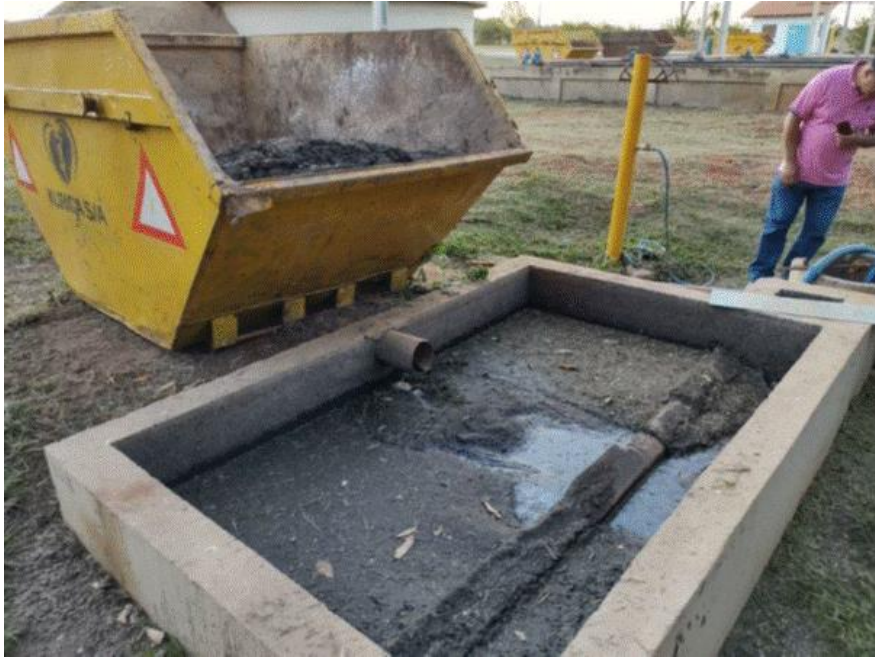
Figura 103 - Caixa de areais e caçamba. Fonte: AEGEA
