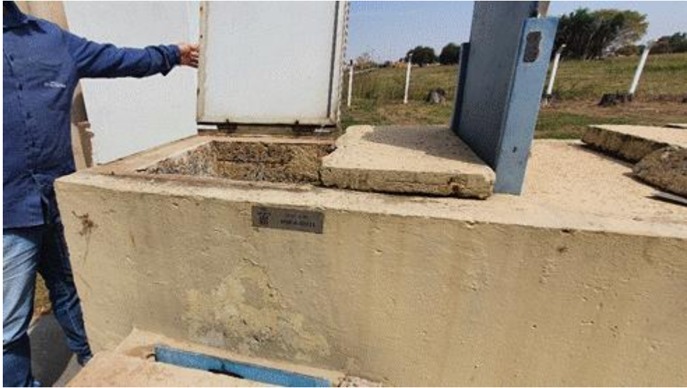
Figura 98- chegada. Fonte: Visita técnica.
