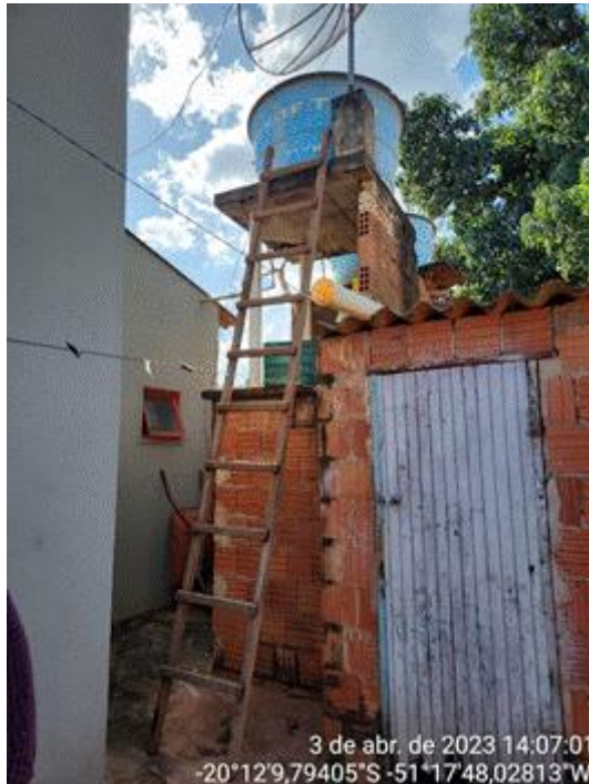
Figura 121 - Reservatório abastecido por poço, em residência. Fonte: Visita técnica.
