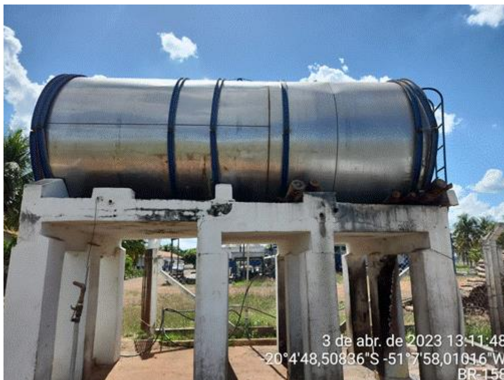
Figura 23. Tanque de armazenamento do soro gerado no laticínio
