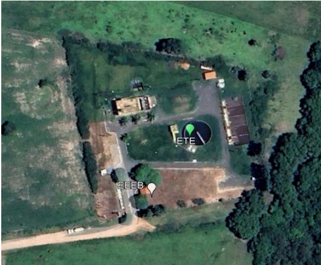
Figura 92 - Localização da EEEB de Aparecida do Taboado. Fonte: Google Earth.
