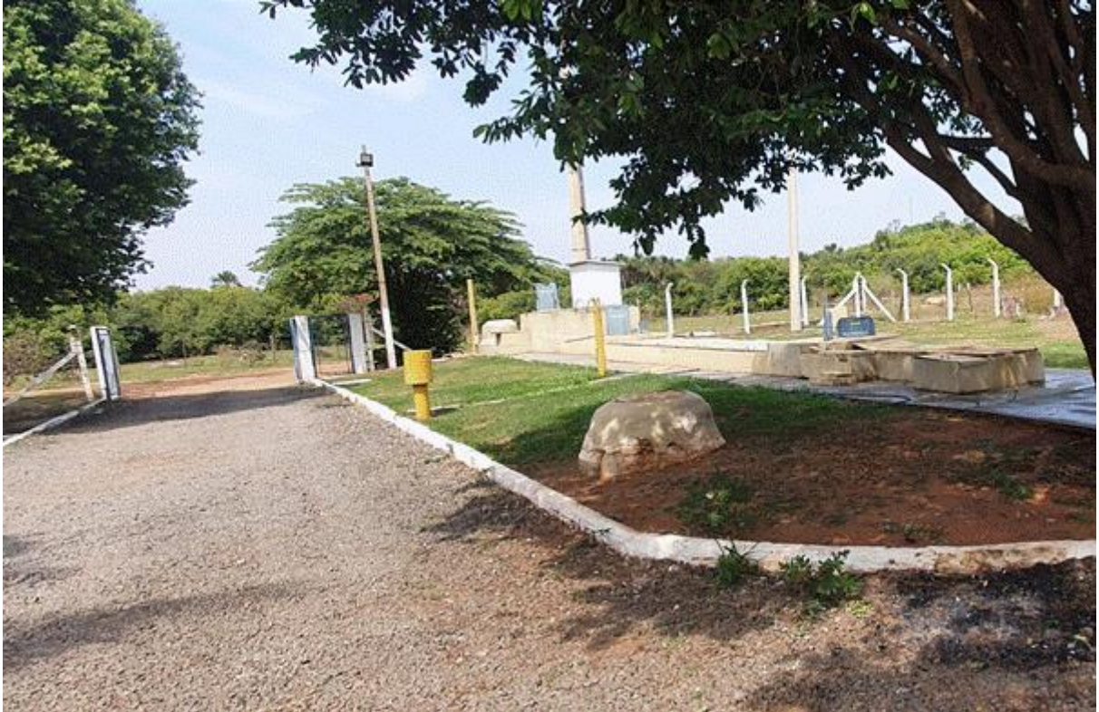
Figura 97 – Entrada da Área da ETE e Tratamento Preliminar a Direita. Fonte: visita técnica.
